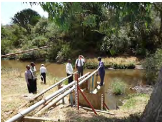
ナロク浄水場の取水場所。かなり濁っている。
