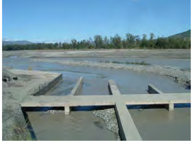
ラクロ川右岸にあるラクロ灌漑施設の取水口の様子。
