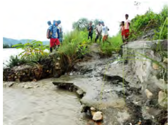
図 2 - 12 破損したインテーク (ヌンレウン灌漑)
