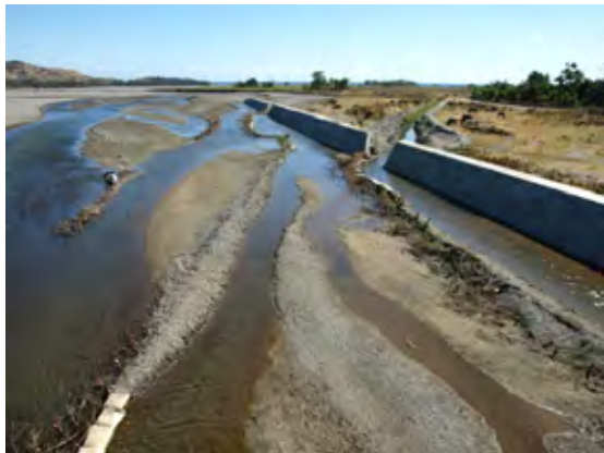
図2 - 13 2008年7月、ローカル・マテリアルによる導水
