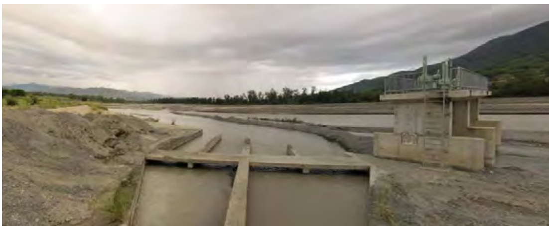
図 2 - 3 ラクロ取水口より上流を望む。右側は土砂吐きゲート
