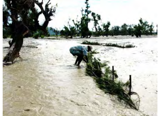
図 2 - 15 分岐点での導水作業
