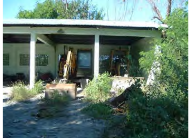
WUAが管理する重機。エクスカベーターは、バケット部分の破損、エンジンオイル漏れのため能力が落ちていくとのことである。
