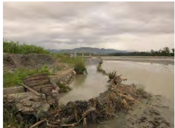
図2 - 5 アスクワカ区域の取水口 流速を落として砂利の流入を防いでいる。
