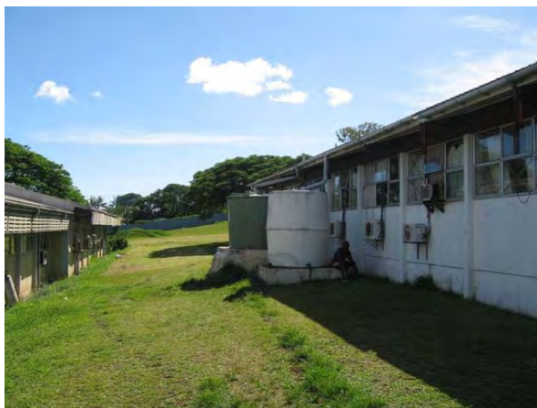
管理棟裏に設けられた天水（雨水）用の水タンク。一つは飲料用に、もう一つは左側の検査棟の蒸留水製造用に使用されている。
