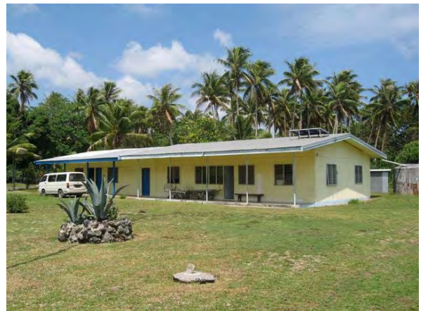
エファテ島北部のヘルスセンター (Paonangisu Health Center) の診察棟。このセンターには JOCV 隊員が配属されている。
