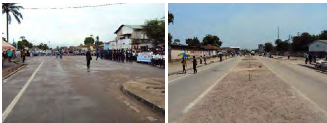
Fig.4.6.11 Accomplissement de la construction
