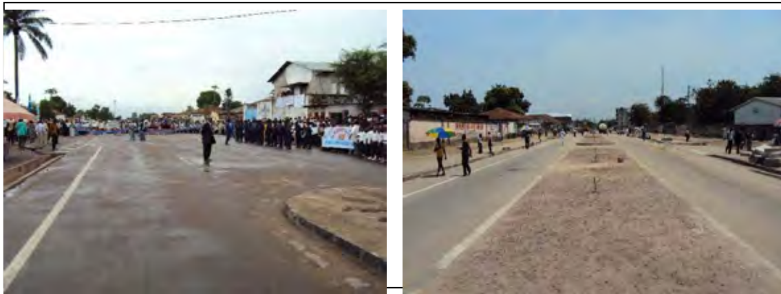
図 8.16 ルエンバ道路工事完了写真
