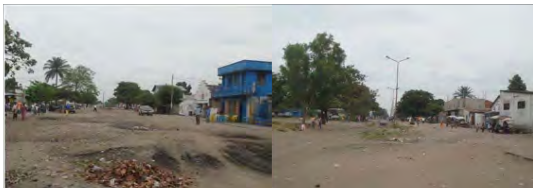
図 8.10 工事前の状況
