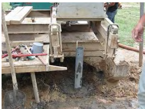
Фото 3 : Установка направляющей трубы скважинного инклинометра
