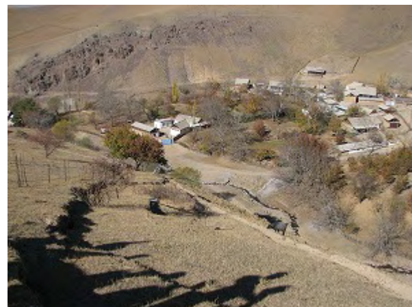
Участок для мониторинга3(Бедренгет) Оползень находится вблизи небольших разрушений поверхностных слоев грунта в Ангренском районе. Вниз по течению расположено небольшое поселение.
