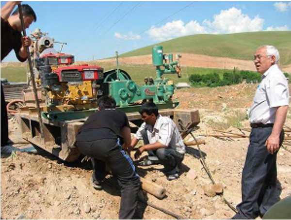
Транспортировка буровой машины
