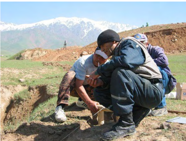
Монтаж экстензометра(глубинный)(Танга Топди)
