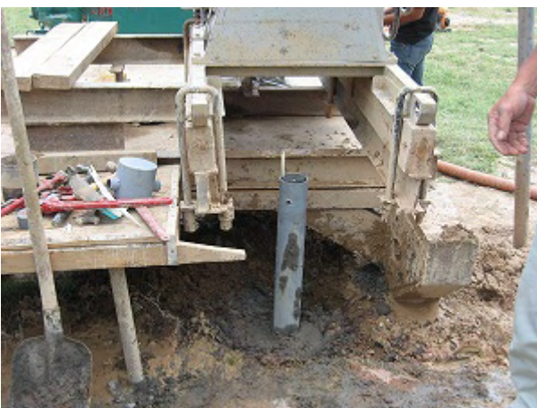
Условия монтажа обсадных труб для инклинометра
