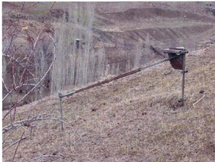
図 3：現場に設置されている変位計（伸縮計）
