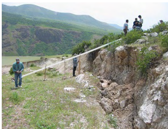
写真 8：伸縮計設置完了後の状況（通常設置型）
