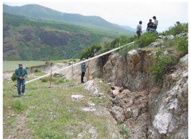
伸縮計設置（通常設置型）の様子（チェツ）
