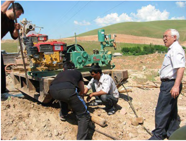
ボーリング運搬の様子
