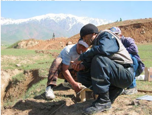
伸縮計設置（埋設型）の様子（タンガトプディ）
