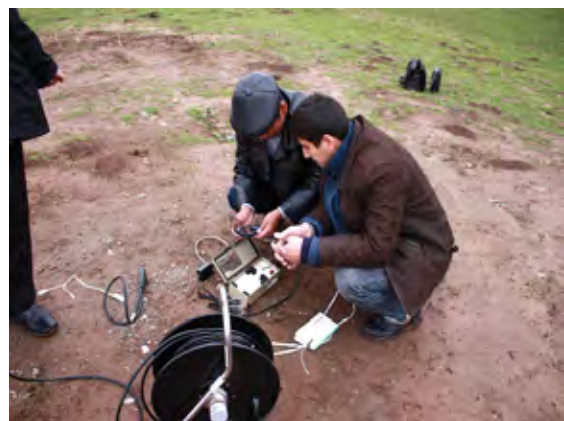
写真 4 : C/Pによる孔内傾斜計測定の様子
