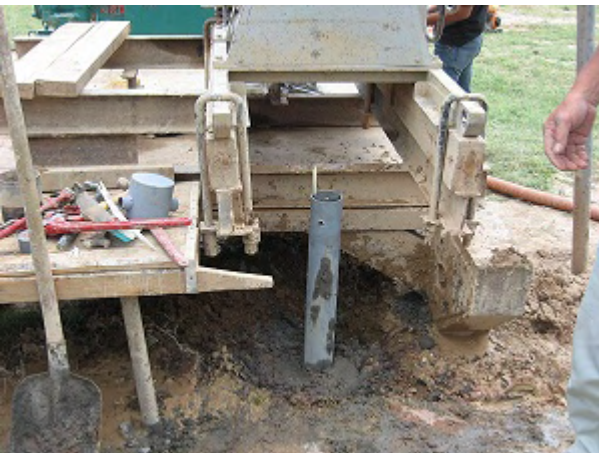
孔内傾斜計保護管設置状況
