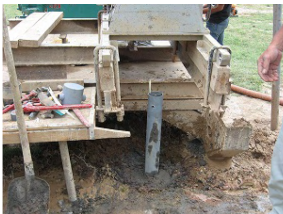
写真 3 : 孔内傾斜計ガイドパイプ設置状況
