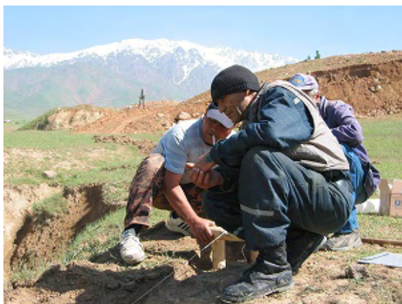
写真 7：伸縮計設置（埋設型）の様子
