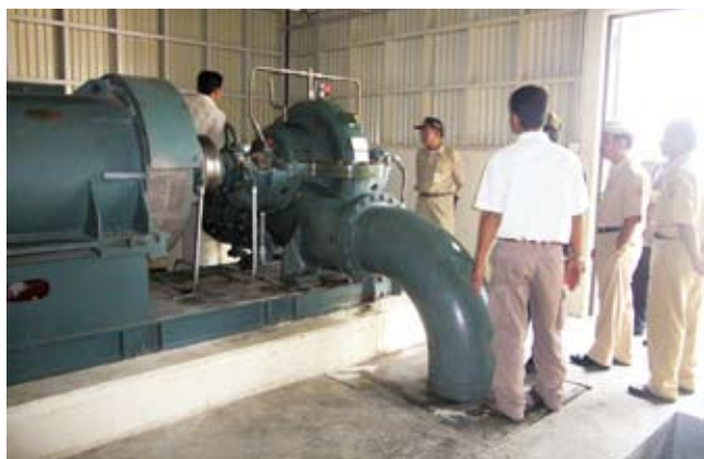
発電機の点検の様子
