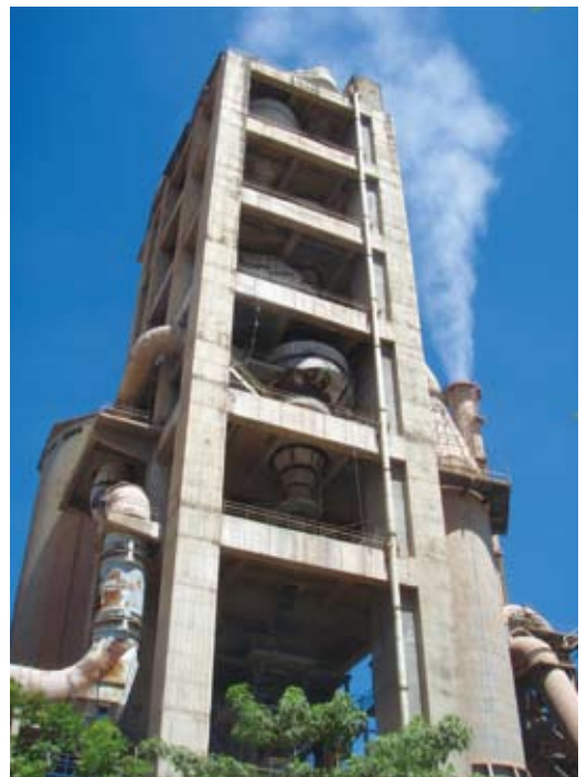
工場で発生する蒸気を発電に活用するシステムの供与も計画されている
