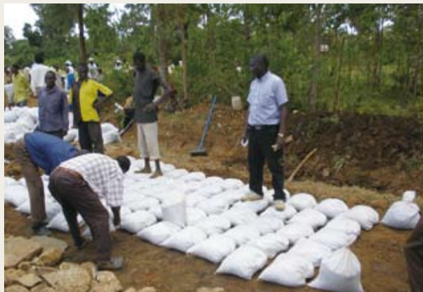
農民グループによる土のうを使った農村道の修復。農村道の整備を協力して行うことで、グループの結束が強まった
