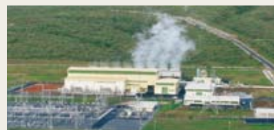
運転中の既設オルカリアII地熱発電所
