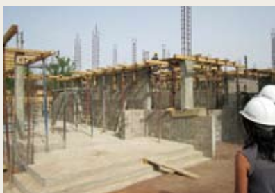
建設が進む保健センター
