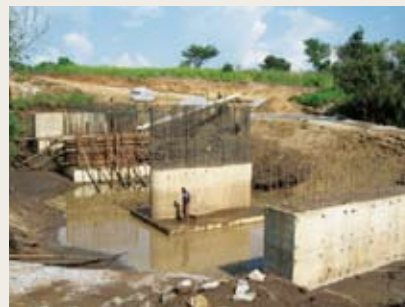
オトゥエアナカ間の橋梁建設現場
