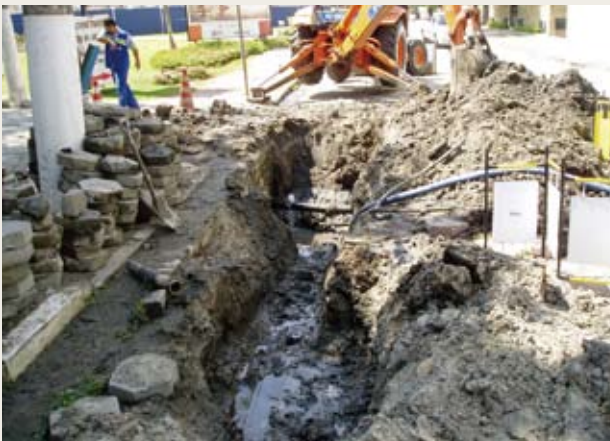
配水管の漏水と修理
