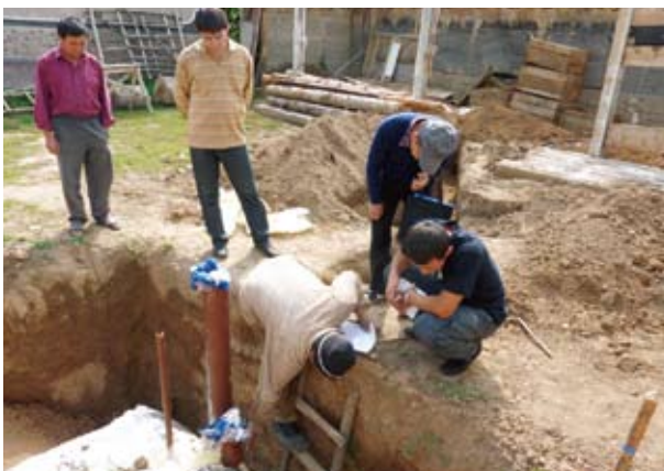
バイオガスプラント建設風景
