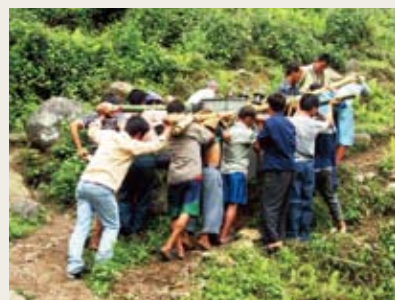
変圧器を担いで山道を登っていく(ブータンの地方電化)
