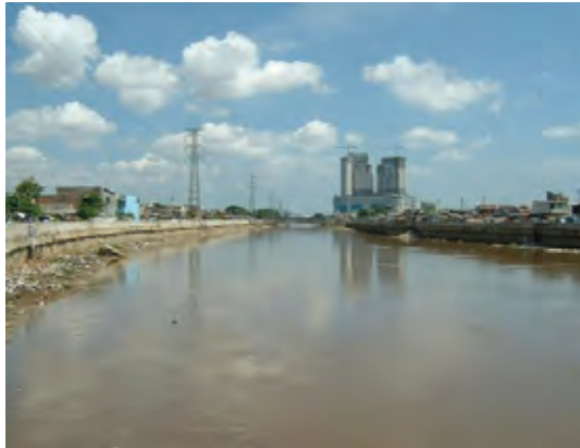
改修された西部放水路
