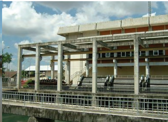
西部放水路に建設されたポンプ場
