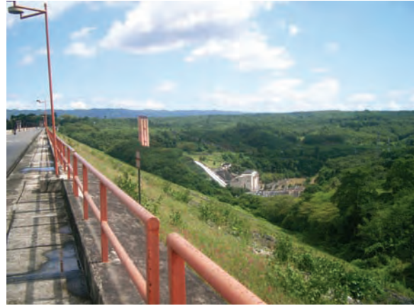
カランカテス多目的ダム下流側発電水路
