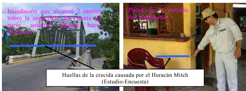
Figura 2-2-2-2.9 Nivel Máximo de Agua Alcanzado durante el Ataque del Huracán Mitch sobre el Puente Las Banderas
