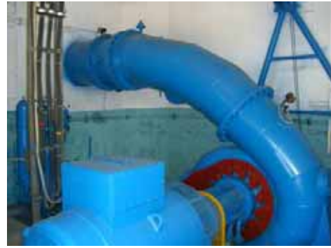
Tubería de toma de agua para generación eléctrica y canal de turbina
