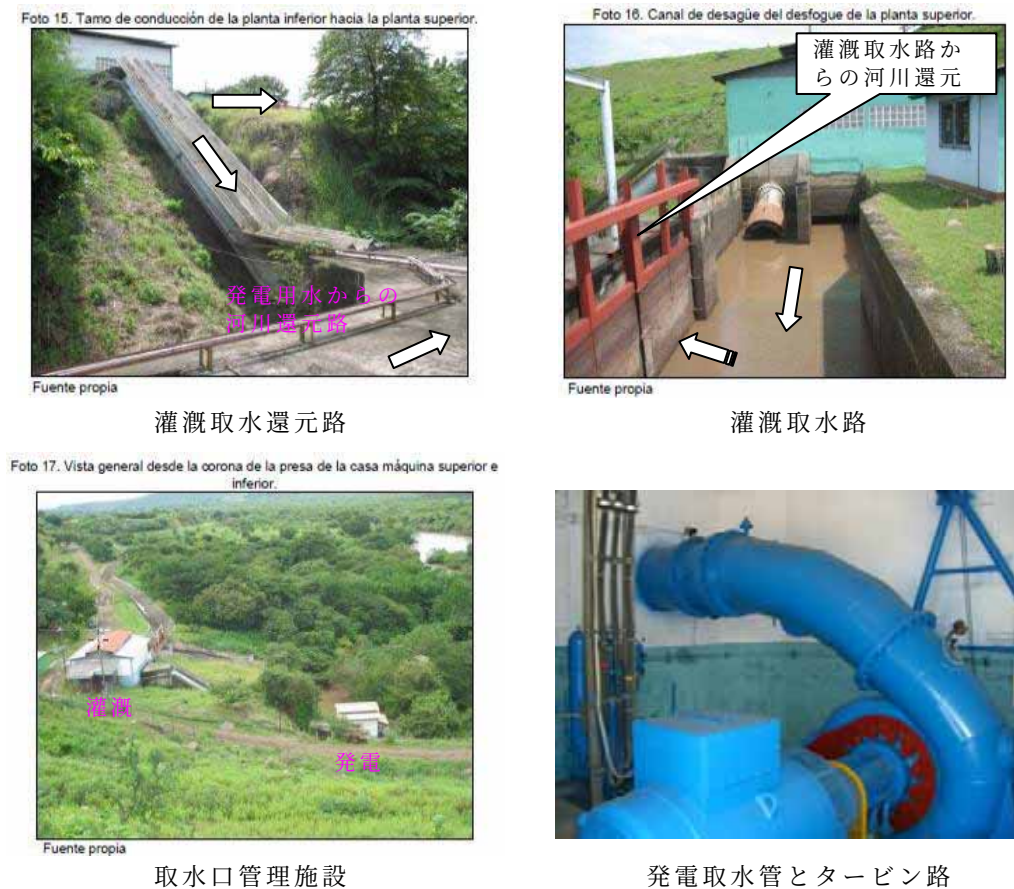
図 3-2-2-2.12 ラス・カノアス・ダムの使用状況
