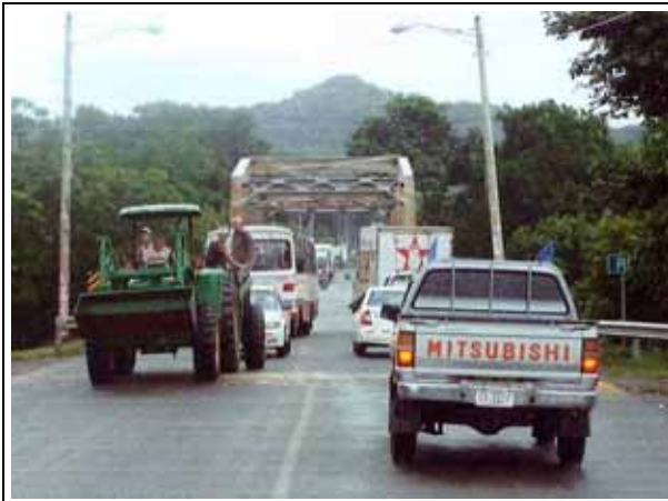
写真-25：道路幅員が1車線しかないため、渋滞が発生している。
