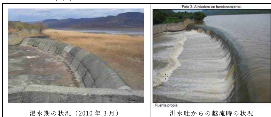
図 3-2-2-2.10 ラス・カノアス・ダムの洪水吐の状況
