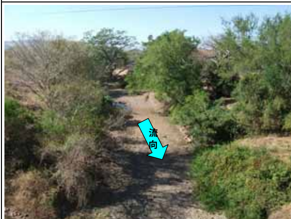
写真-23：橋梁上流側の河川・河道は乾季には水位がなく、一部で露呈している岩盤が見受けられる。
