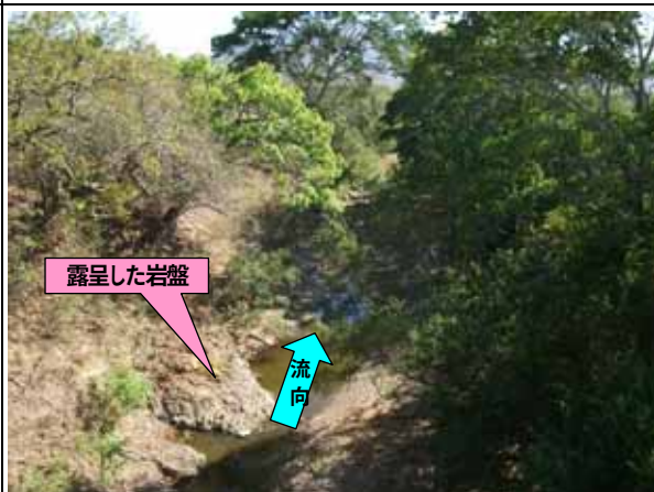
写真-24：橋梁下流側の河川・河道は湾曲しており、一部で岩盤が露呈している。周辺住民の洗濯場でもある。
