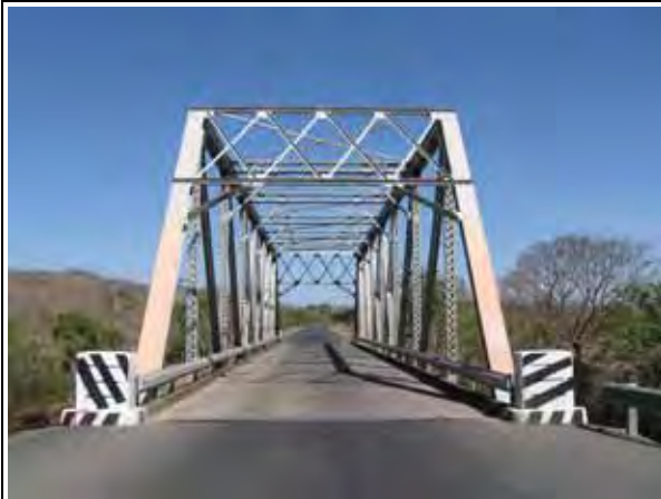
写真-19：橋梁幅員は6.1m、橋門構下面（中央）のクリアランスは4.8mである。渋滞は発生していない。
