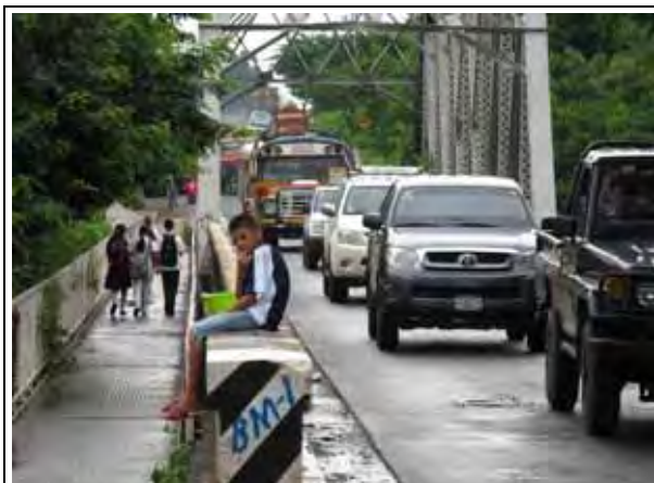
写真-7：道路幅員が1車線しかないため、渋滞が発生している。
