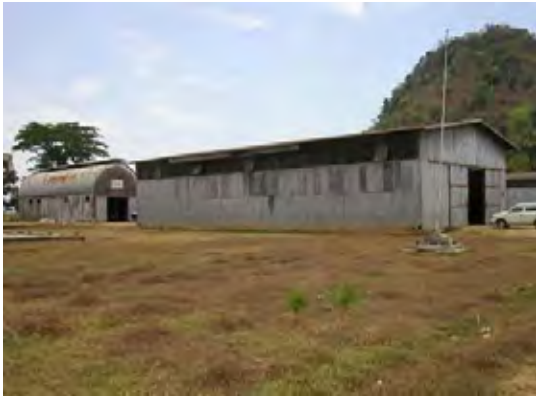
写真7 エンドユーザー、PTペルタニ所有の倉庫。肥料のみならず、収穫したコメやトウモロコシ、種籾やトウモロコシの種も保管する。(タカラール県)
