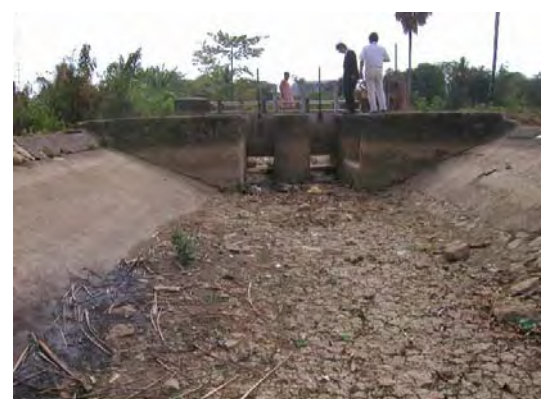
写真12 パサナンゲン村農業共同組合の農地に水を供給する灌漑施設。水源は、上流に設置されているダム。雨期になり、ダムの貯水量が一定以上になると、水の供給が始まる。(パングケップ県)
