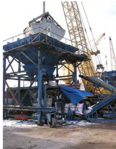
写真6 バルクで荷揚げされたあと、直ぐに袋詰めが行われ、ベルトコンベアーでトラックに積み込まれる。同様の袋詰め機が4台稼働しており、1台で600MT/日の袋詰めが可能。（マカッサル港）
