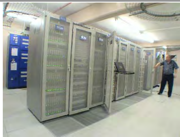
設置作業中の高速コンピュータ （高度コンピュータ・センター内）
