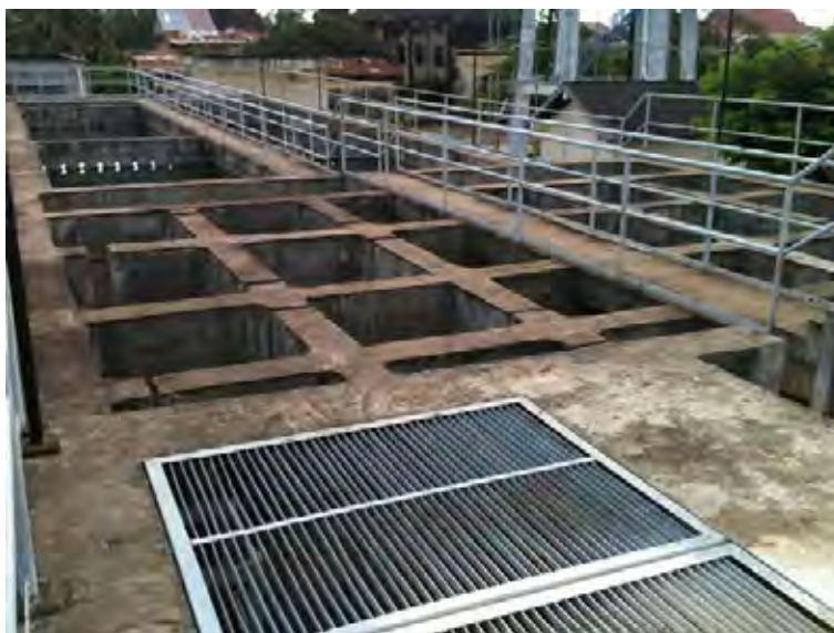
写真：フロッキュレータ及び沈殿池の状況
