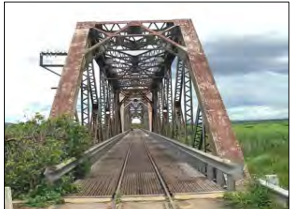
⑤ 縦断がレベルに保たれている橋体
