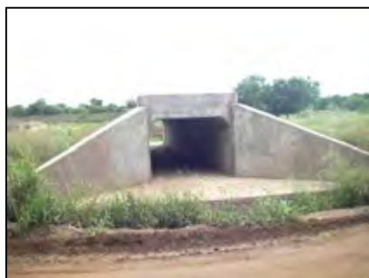
道路整備によりほぼ完成している M1 道路上のボックスカルバート
