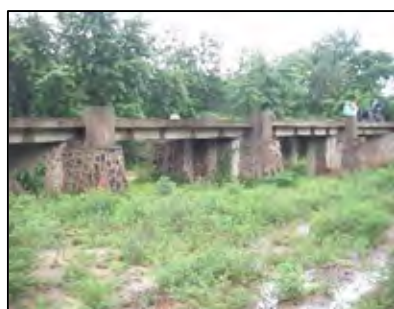
チノロ橋全景（側面）
