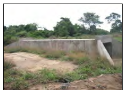
道路整備によりほぼ完成している M1 道路上のボックスカルバート
