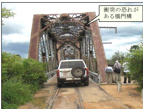
⑥ 幅員が狭く交互通行が困難なシレ橋
