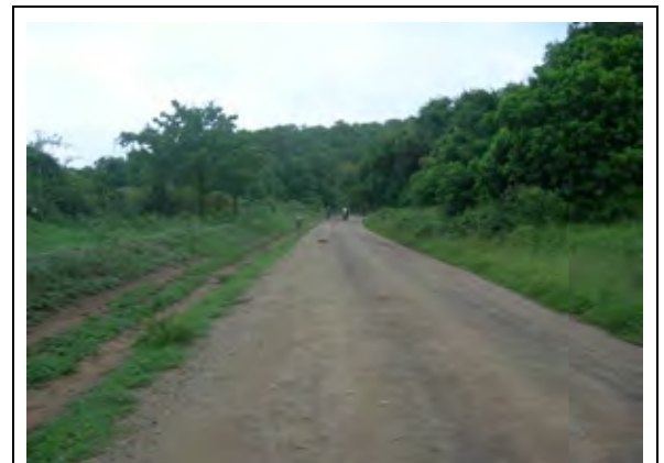
土道の上に砂利を散布し転圧した砂利道
