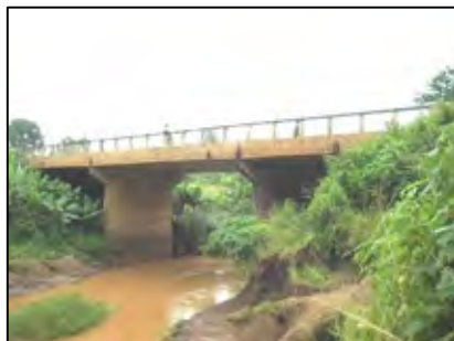
ヌスワジ川橋全景（側面）
