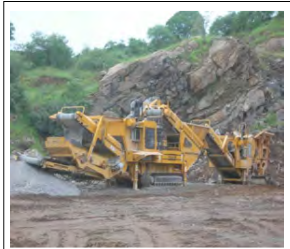
S152 沿線のチクワワ付近における砕石場
