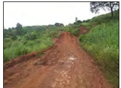
ぬかるみで通行不能な道路
