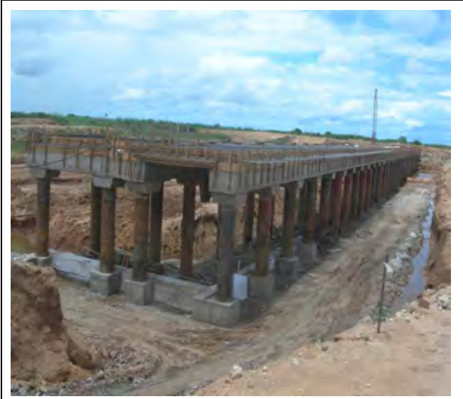
ンサンジェ港の岸壁建設工事現場 写真の左側が岸壁前面で、右側は岸壁後背地として倉庫などが建設される予定。なお、岸壁及び護岸工事が完成したらシレ川から水を引き込む予定となっている。
