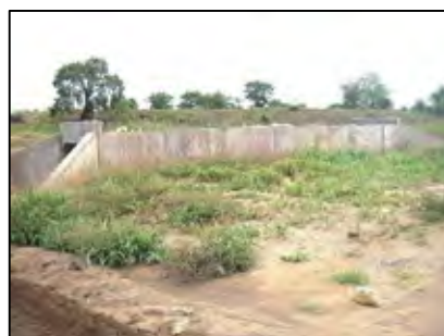
道路整備によりほぼ完成している M1 道路上のボックスカルバート
