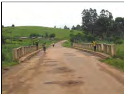
ヌスワジ川橋全景（正面）
