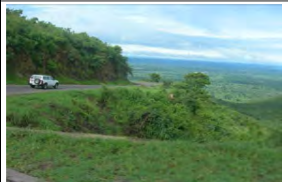
ブランタイヤから約40km付近。平面線形、縦断線形も極めて悪い。写真右側の平地にはシレ川が眺められる。
