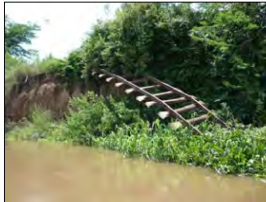
路盤崩壊例 2
