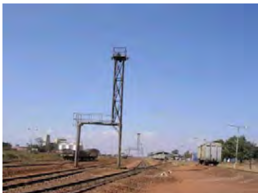
貨物ヤード (リロングウェ駅)
