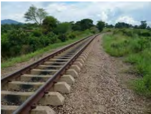
改修された軌道 (バラカ付近)
