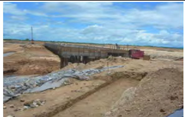
ンサンジェ港建設中(左が岸壁前面、右が後背地)
