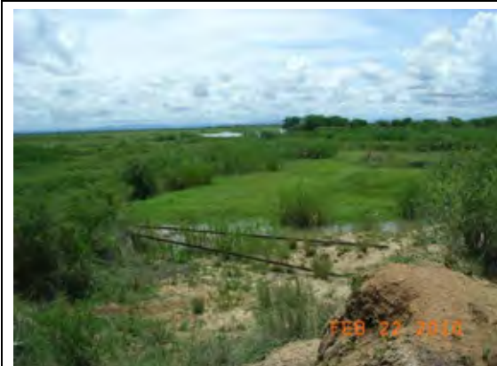
旧鉄道ルート盛土流失区間北側の湿地
