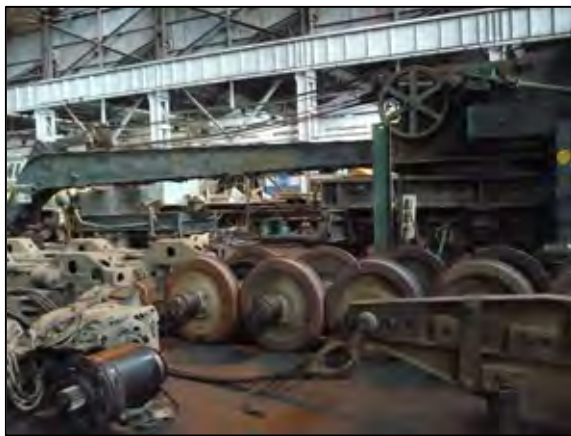
車両工場内の様子
