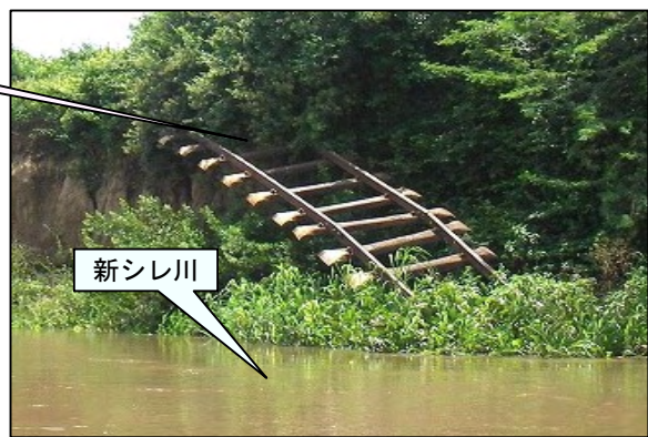
流失した鉄道線路部(マカンガ側)
