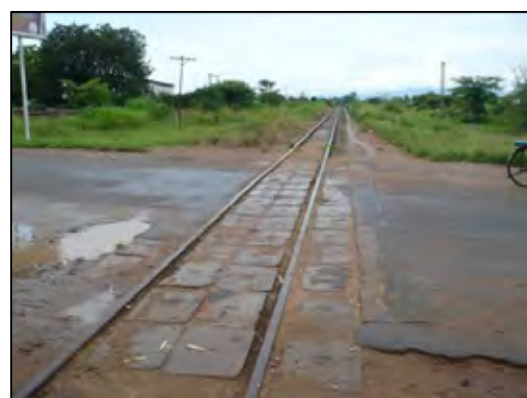
保安装置の無い踏み切り
