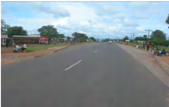
バス停はコンクリート舗装となっている
