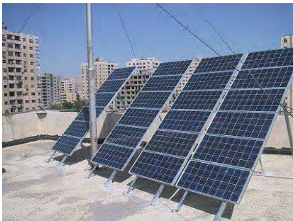
NERC 庁舎屋上
