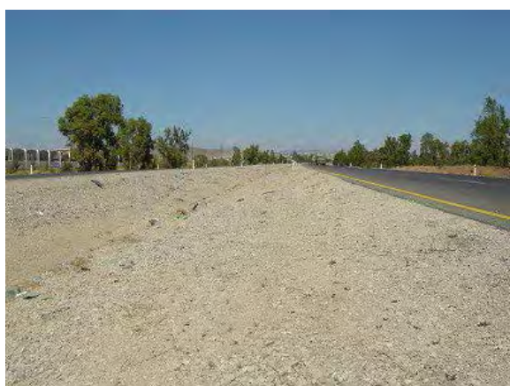
中央分離帯 (街灯設置位置)
