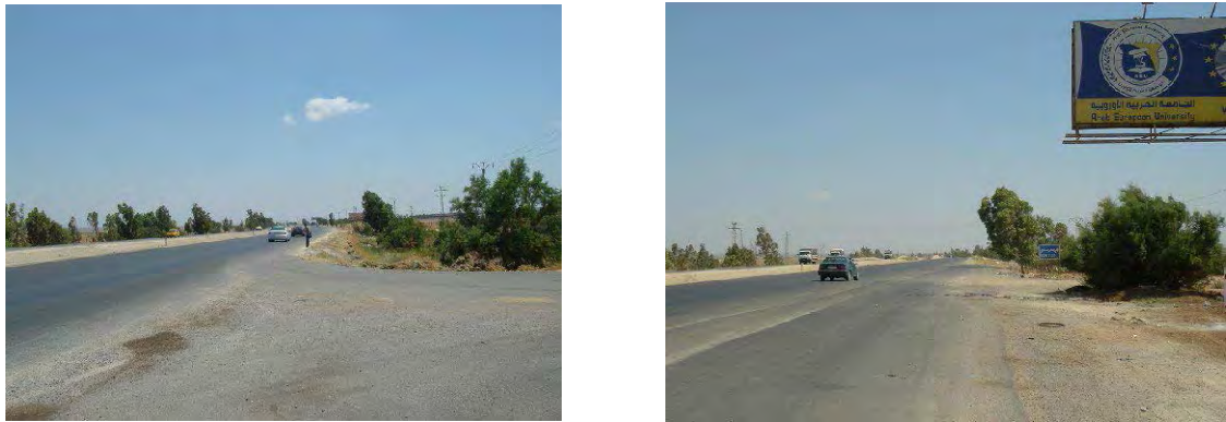
図2-5 調査対象道路の状況
