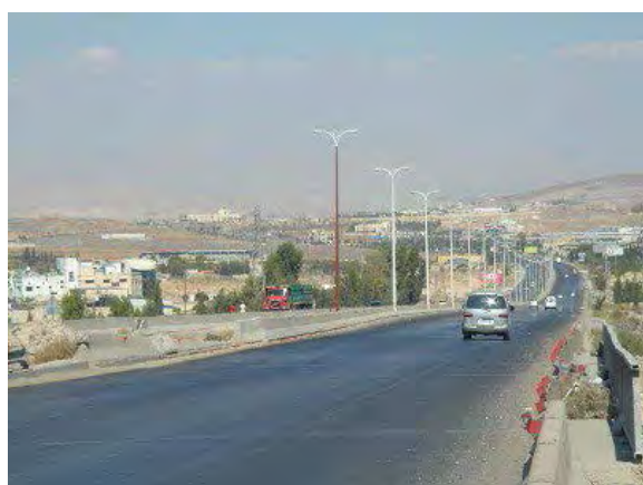
Damascus-Jordan 道路 (既設街灯設置区間)
