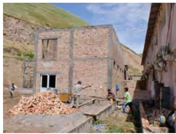
写真 3-42 建設中建屋；全面改装中
