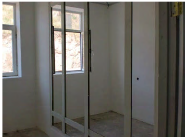
写真 3-46 試験室； 改装部分
