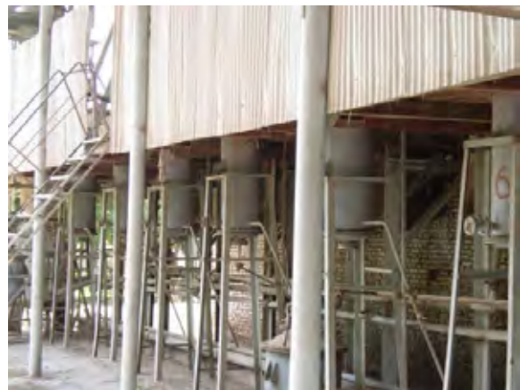
写真 2-2 抽出工場；放置されている
