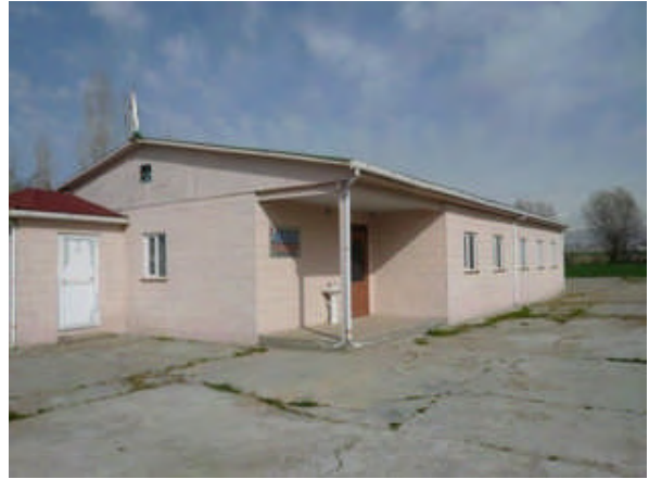
写真 3-14 試験圃場研修室（日本大使館支援）； 将来、講習等で利用可能である。
