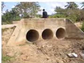
814 Pipe Culvert 3@D1200
