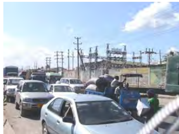
タザラ：マンデラ道路脇、北東側 ROW 内にある TANESCO 変電所
