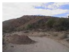
未舗装道路の改良
