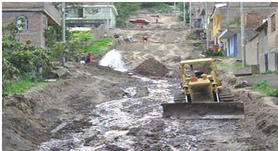
地元自治体が活用している道路維持管理用機材
