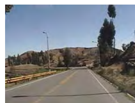
幹線道路の改良
