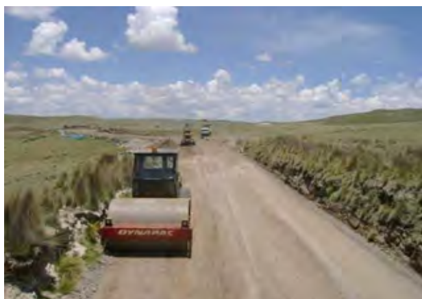
Sub rasante による突き固め
