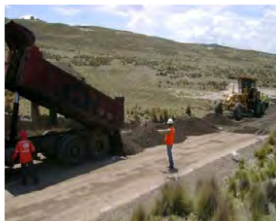
路盤材の敷設
