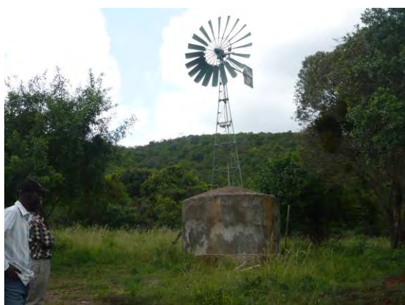
風力ポンプ動力により中学校に給水
