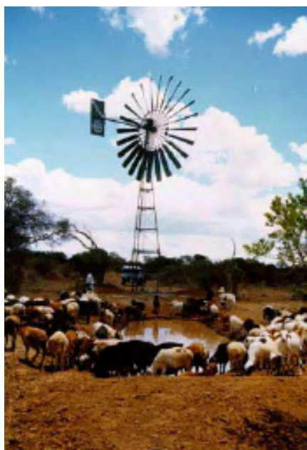
風力ポンプの設置状況
