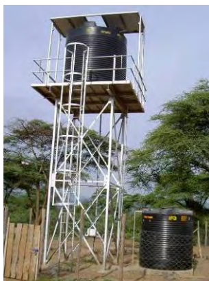
太陽光揚水施設と高架水槽
