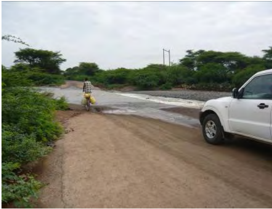
(河川横断部)幹線道路でも橋がない
