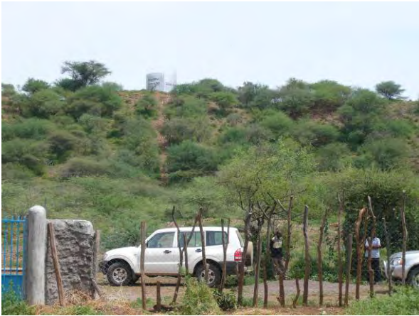
Endoa 村と Loberes 村 広域給水施設 政府及び NGO 支援による深井戸 63m、商用電力、配水 タンク 230m 3 、公共水栓 3 箇所、各戸接続 100 件
