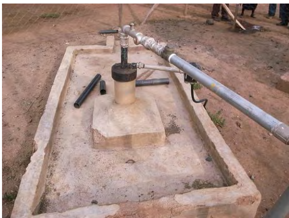
同上。ハンドポンプを撤去し、水中ポンプを設置
