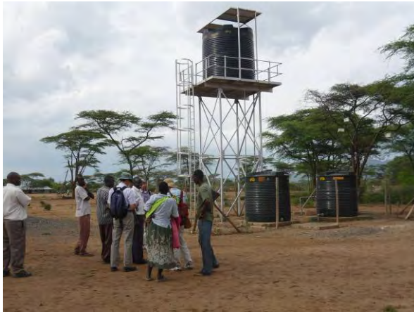
Chebinyiny 村 太陽光式レベル 1.5 施設+フッ素除去施設 ローカル NGO によりハンドポンプ井戸を太陽光に改造した施設
