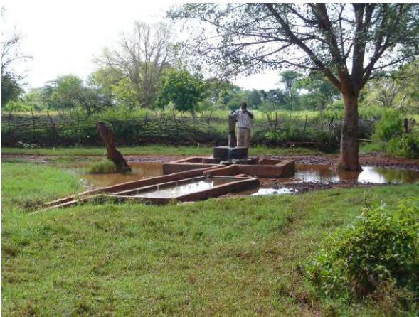
Kanoo 村と Eron 村の間に位置したレベル1 施設 手掘り浅井戸に設置されたハンドポンプ施設。 定期的な料金徴収はなく修理時のみ徴収。
