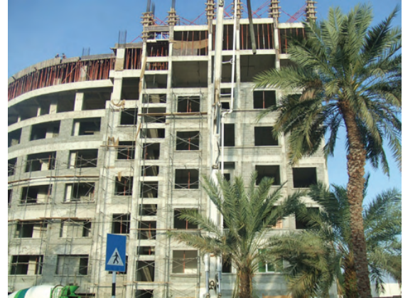
図 6-4 建設中のビル 開口部が広い
