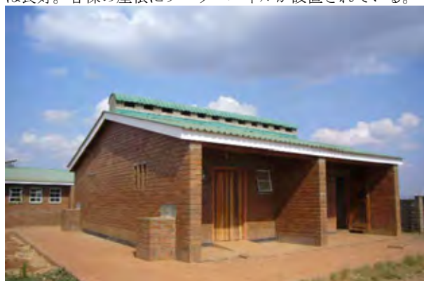
便所棟は男女及び教員、身障者用が一体となっている。通気が悪く、設計上の改善が必要
