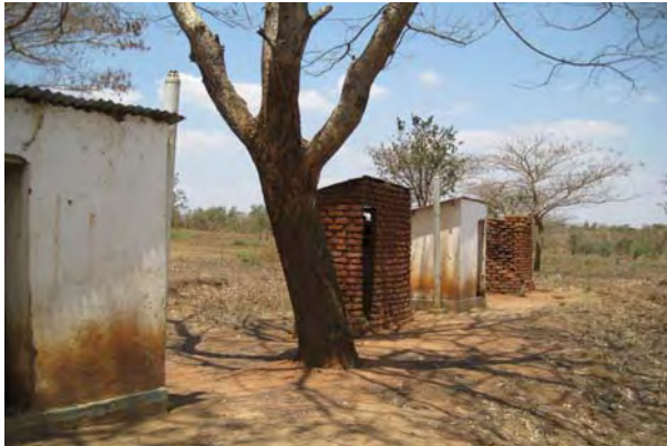
便所は直接浸透式であり、ブース毎に独立している。
