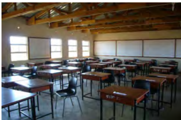
教室内部。トラスのピッチが狭く、堅牢な構造。施工品質も良好である。
