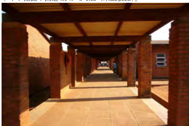
教室棟12教室(4学年×3)の大規模校。 各棟の間は屋根付きの廊下で接続されている。
