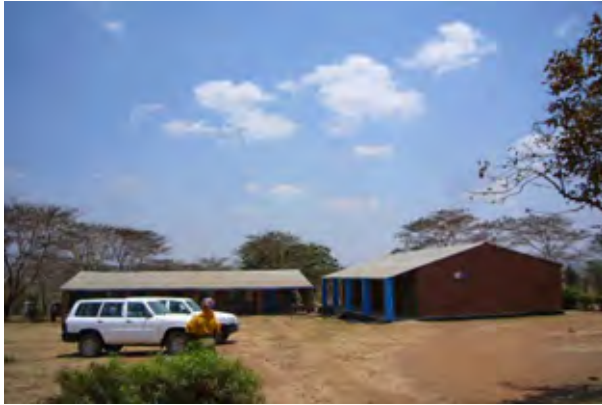
教室棟2棟と便所棟のみにより構成されている。敷地面積は広いが、緩やかな傾斜地である。
