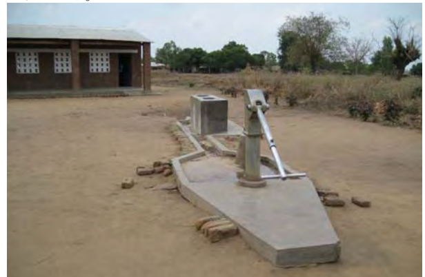
敷地内の井戸。
