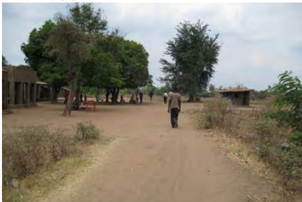
アクセス道路方面から見た校舎群。国道3号線から4.5kmの未舗装路を介してサイトに接続する。
