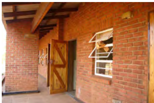
レンガ組積造による構造。施工品質は良好。
