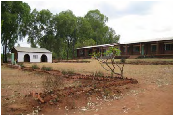
教室棟 2 棟及び管理棟により構成されている。敷地は傾斜地である。
