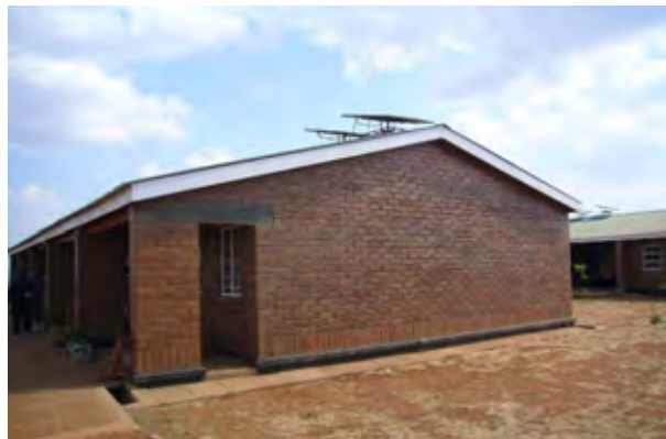
SSB による組積造。個々のブロックの精度が良く、施工品質は良好。各棟の屋根にソーラーパネルが設置されている。
