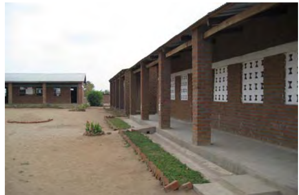
教室棟2棟、管理棟1棟、教員住居1棟、便所棟により構成されている。
