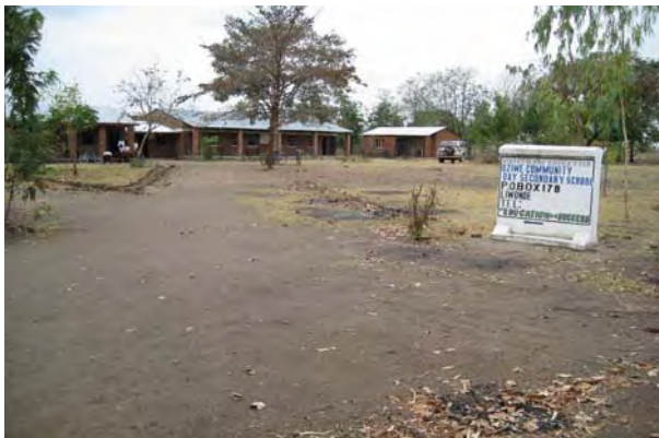
アクセス道路方面から見た校舎群。国道 3 号線から 11km の未舗装路を介してサイトに接続する。
