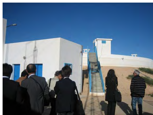
Figure 3-3 Réservoirs de distribution existants
