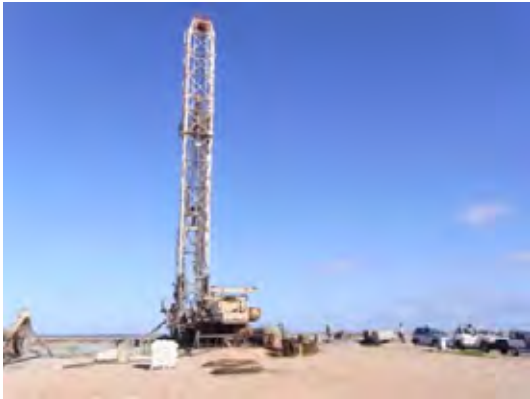
井戸近辺にプラントを建設予定
