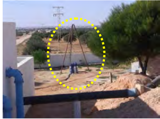
掘削済み井戸(5 l/秒)。建設中の井戸の揚水量が十分でない場合は、プラントへの導水が必要となる。
