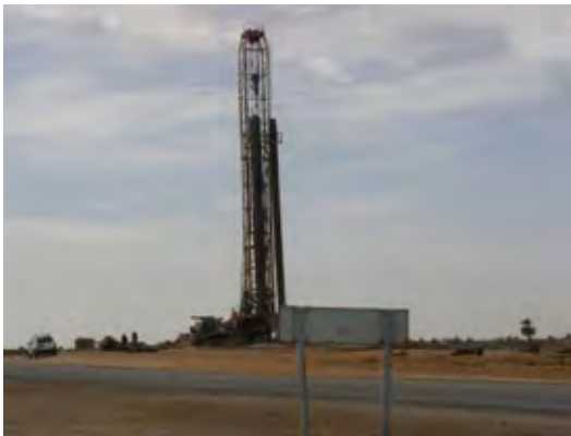
掘削終了、井戸洗浄についても終了している。
