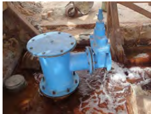
揚水試験結果より水温 45℃、水量は 31 ℓ/秒である。
