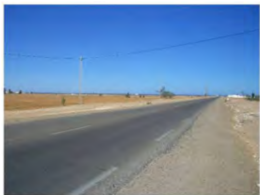
深井戸前の国道脇に送水管を設置する。
