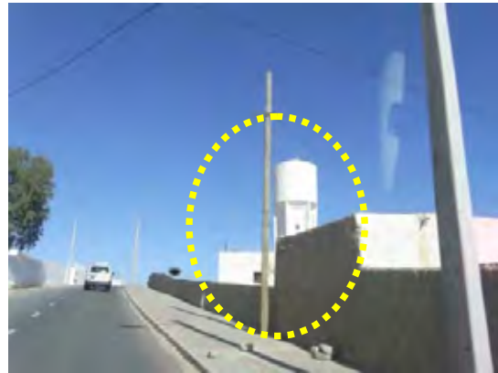
地区内の高架水槽(250m 3 )。上記配水地と同様に2系統から導水し、施設内で混合される。
