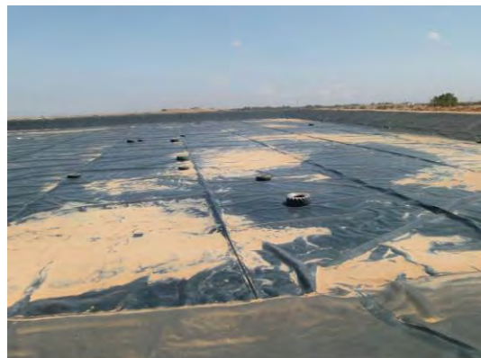
マトマタに施工された天日蒸発ピット。施工済みだが、まだ使用されていない。
