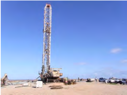
井戸近辺にプラントを建設予定
