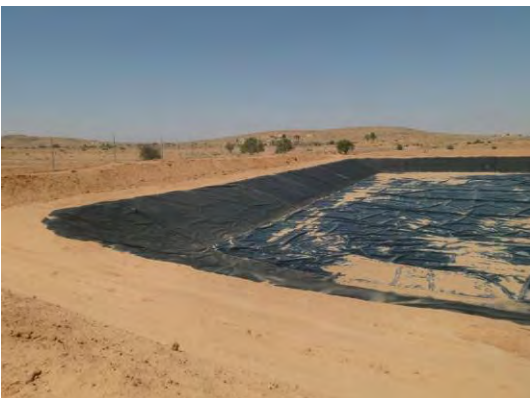
マトマタに施工された天日蒸発ピット。施工済みだが、まだ使用されていない。
