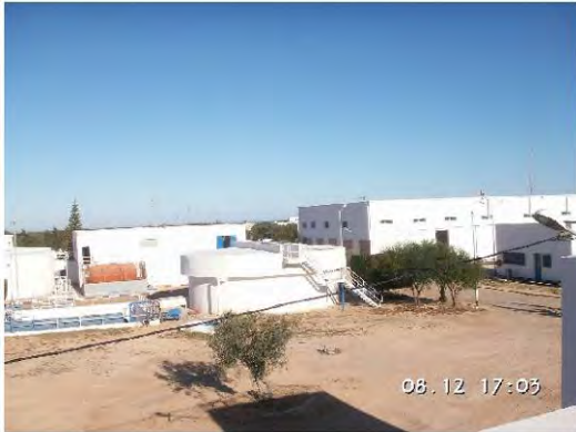
ジェルバ淡水化プラントと同等の施設
