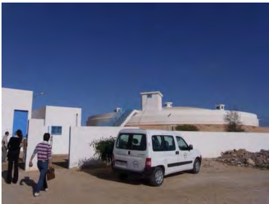
淡水化プラントから約 6km の送水管により送水予定の配水池施設 (1974 年完工)。敷地内には 2,500m 3 (左) と 2,000m 3 (右奥) が併設されている。周辺はオリーブ畑が続いており、市内まで約 7km。
