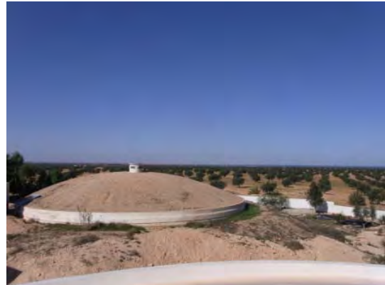
淡水化プラントから約 6km の送水管により送水予定の配水池施設 (1974 年完工)。敷地内には 2,500m 3 (左) と 2,000m 3 (右奥) が併設されている。周辺はオリーブ畑が続いており、市内まで約 7km。
