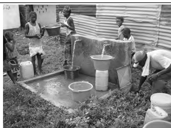
写真-2： R-01 既存公共水栓の注水試験
