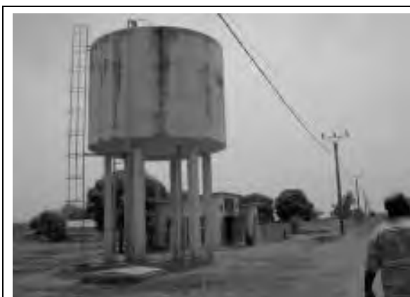
写真-1： R-01 既存給水施設に導入された商用電力（NAWEC）の電力
