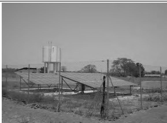
写真-7：下流州 (L-10 Massenbe)。第二次無償 (2006) で建設したソーラー式給水施設は、順調に稼働している。
