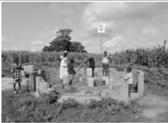
既存施設確認調査 3 ハンドポンプ付深井戸 N-10 フラクンダ隣村
