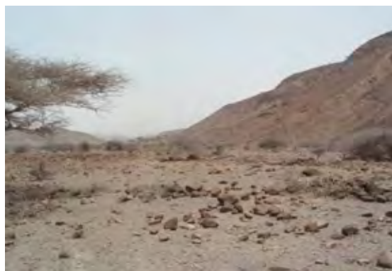
写真-17 掘削要請地点
