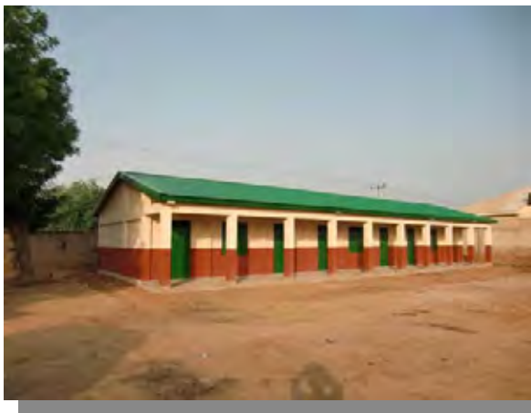
完成状況 Kawaji Jigiriya 校・Nassarawa LGA
