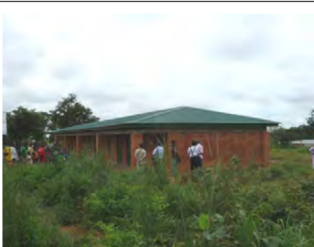
焼成煉瓦により内・外観が仕上げられているため、経年劣化による塗装の塗り替えなどの維持管理費が軽減できる。
