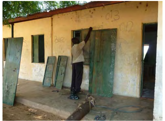
学校職員による建具の補修。学校によっては、維持管理体制が確立されており、日常のメンテナンスが行われている。 (18 Jalli P.S, Dawakin Tofa LGA)
