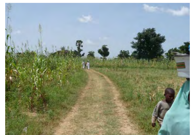
敷地内へのアクセス道路。雨季における資材の運搬が困難な農道が約40km以上も続く。(37 Kuraku P.S, Shanono LGA)
