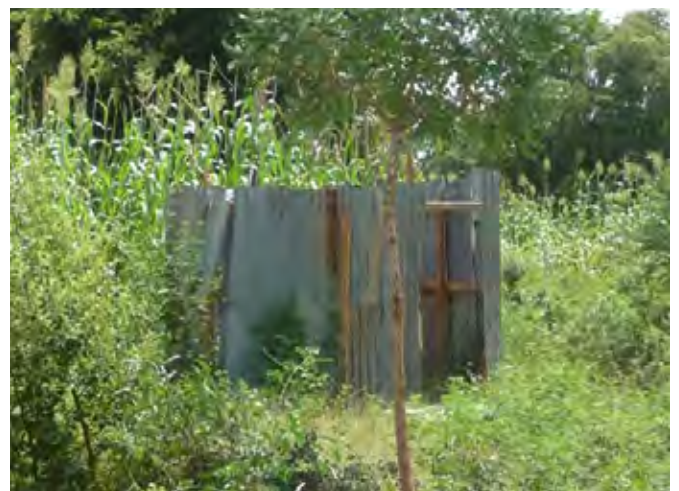
屋根も建具も無く、トタン板で囲っただけのトイレ。利用されずに放置されているものも多い。(45 Rumin Dako, Bagwai LGA)
