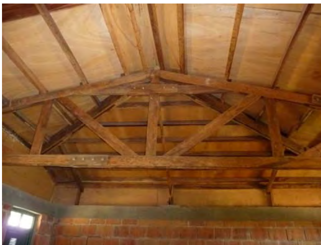
木造トラスによる屋根架構。天井がないことにより、空気が流れる空間が大きいので、教室内は快適・開放感のある空間となっている。
