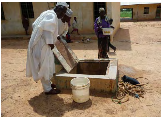
学校敷地内の浅井戸。このような給水施設を有していない学校は、近隣の井戸等より水を運搬し、確保している。(20 Kwa P.S, Dwakin Tofa LGA)
