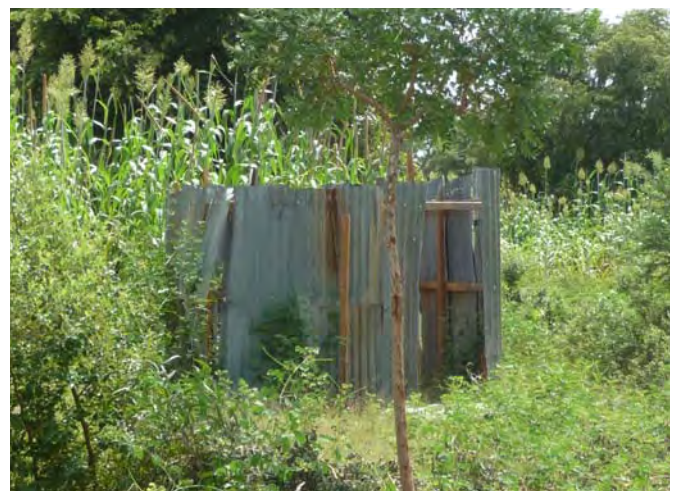
屋根も建具も無く、トタン板で囲っただけのトイレ。利用されずに放置されているものも多い。(45 Rumin Dako, Bagwai LGA)
