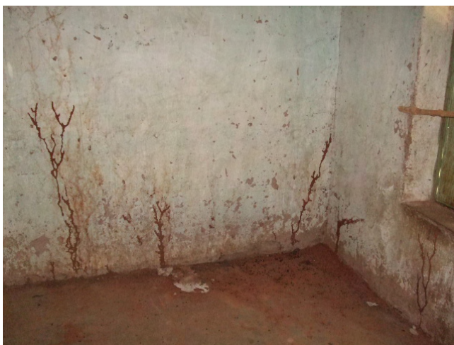
シロアリによる被害の多くは、写真の様に地中から上部の木部へと広がりやがて木材は蝕まれて行く。（44 Dundu P.S, Bunkure LGA）
