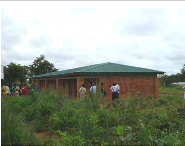
焼成煉瓦により内・外観が仕上げられているため、経年劣化による塗装の塗り替えなどの維持管理費が軽減できる。
