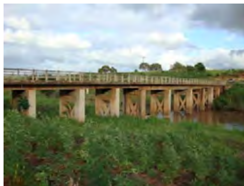
写真-2 ムリケラ橋
