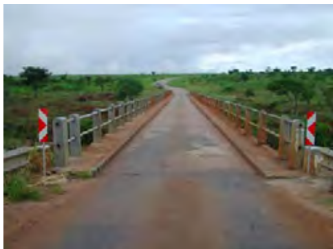
写真-1 ムタバシ橋
