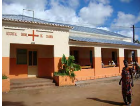
写真-18 クアンバ地方病院
