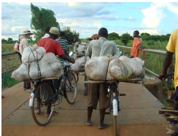
ナムティンブア橋（1 車線の仮橋）。道路は未舗装。人、自転車の往来が頻繁にある。
