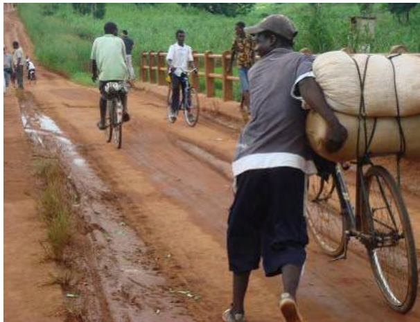
リクンゴ橋（1 車線の橋梁）。道路は未舗装。人、自転車の往来が頻繁にある。
