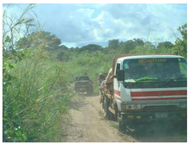
1 車線の未舗装道路。幅員 4m 程度のためすれ違いが困難な区間がある。
