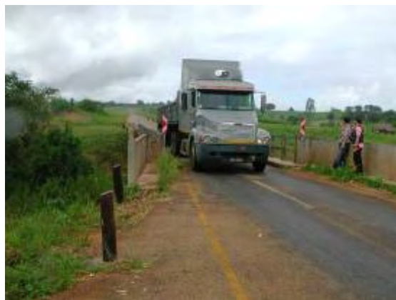
写真 3 6 軸車両が橋梁を通過している様子
