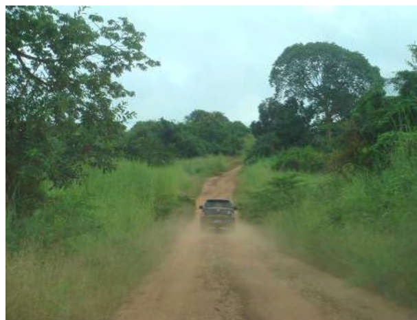
ムツアリークアンバ。迂回路の一部である国道 13 号線。部分的に 1 車線幅員の区間があるが、舗装化・2 車線化が予定されている。
