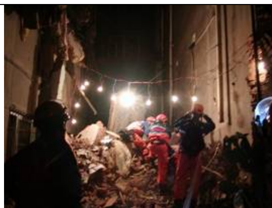
簡易照明による夜間搜索活動
