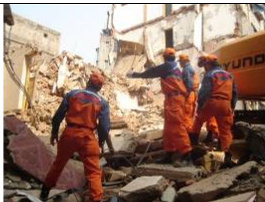
現地の重機を活用しての搜索活動
