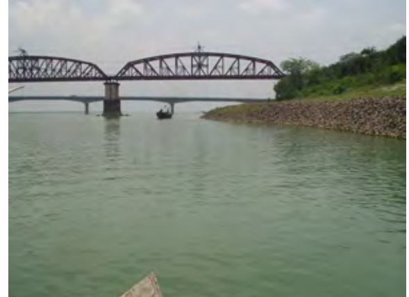
2. ガンジス河の河岸耐浸食箇所 ハーディング鉄道橋右岸
