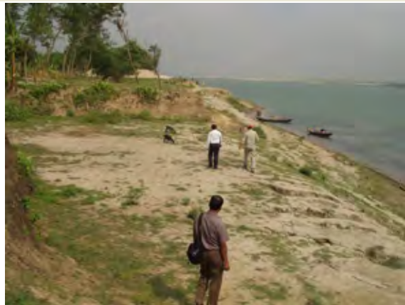
3. ガンジス河の河岸耐浸食箇所 ハーディング橋から約13kmの右岸Talbaria
