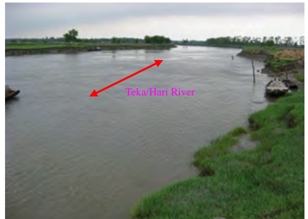
16. Teka/Hari川のTRM実施箇所 (2010.05.21) 河岸浸食、崩落
