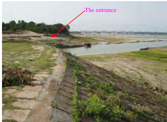
7. GKIP取水路呑口付近の護岸工 (2007.05)
