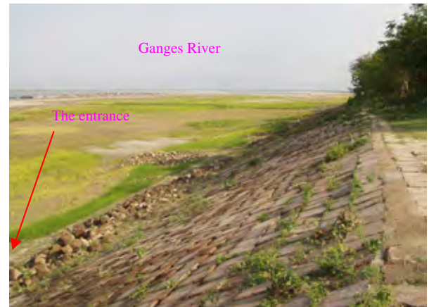
8. GKIP取水路呑口付近の護岸工 (2007.05)
