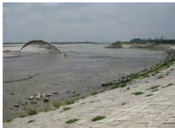
26. ゴライ川分流点浚渫現場 (2010.05.20)
