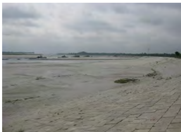
25. ゴライ川分流点浚渫現場 (2010.05.20)
