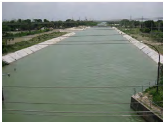
5. GKIPで整備された水路 Distribution Canal (2010.05)
