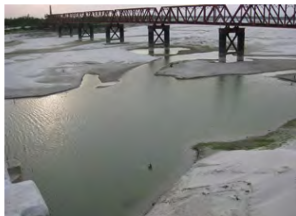
28. ゴライ川分流点から12kmの鉄道橋地点 (2010.05.19) 上流方向
