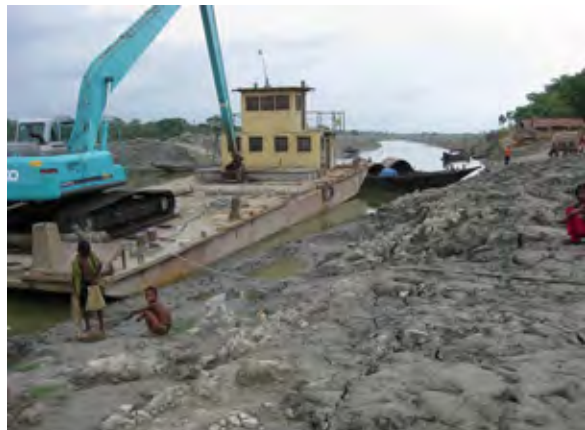
13. コバダック川の掘削現場および再度堆積した河道区間 (2010.05.21) 堆積した河床の掘削
