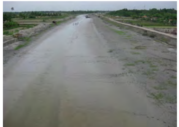
14. コバダック川の掘削現場および再度堆積した河道区間 (2010.05.21) 掘削一年で元状態に戻った (2mの堆積)
