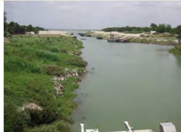
4. GKIPで整備された水路 GK Intake Canal (2010.05)
