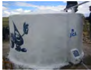
鉄筋セメントタンク
