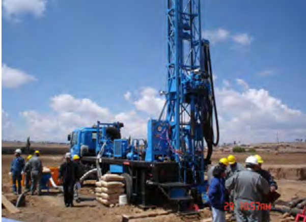
無償資金協力で供与した井戸掘削機材
