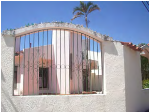
サンタクルス県技術センター建物 (仮事務所)
