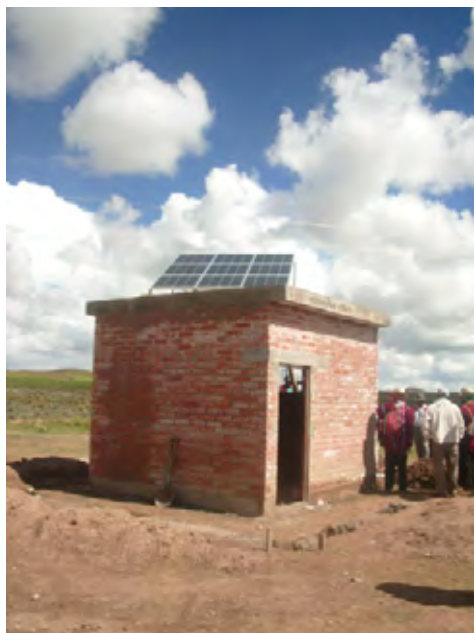
太陽光パネル併設ポンプ
