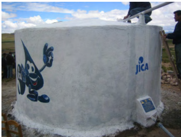
鉄筋セメントタンク
