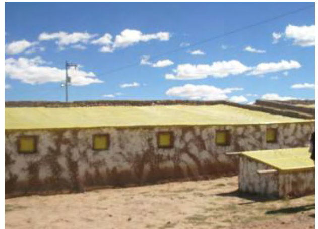
生産的活動 温室の建設（ラパス県）
