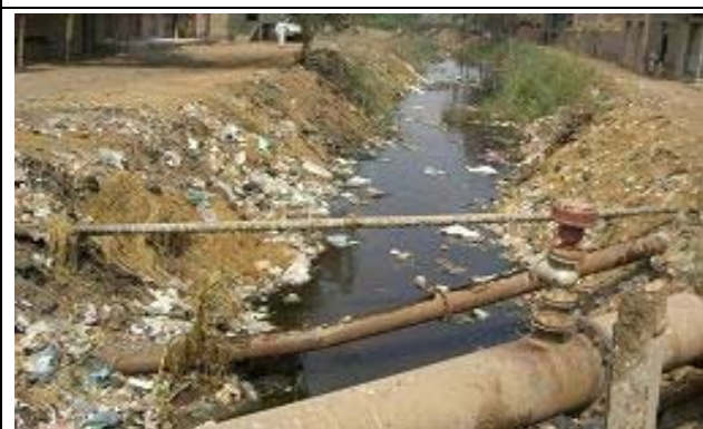
11. ビヤラ排水路上流部 (ビヤラ市街)
