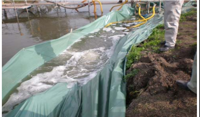
12. MBD 仮排水路での運転時
