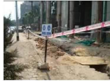
カイロ市内での土木工事 状況
