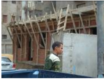
カイロ市内での小規模 建設状況
