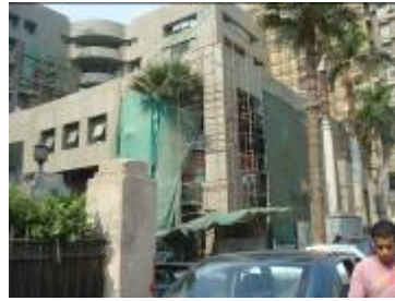
カイロ市内での中規模 建設状況
