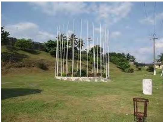
PV モジュール設置箇所 1
